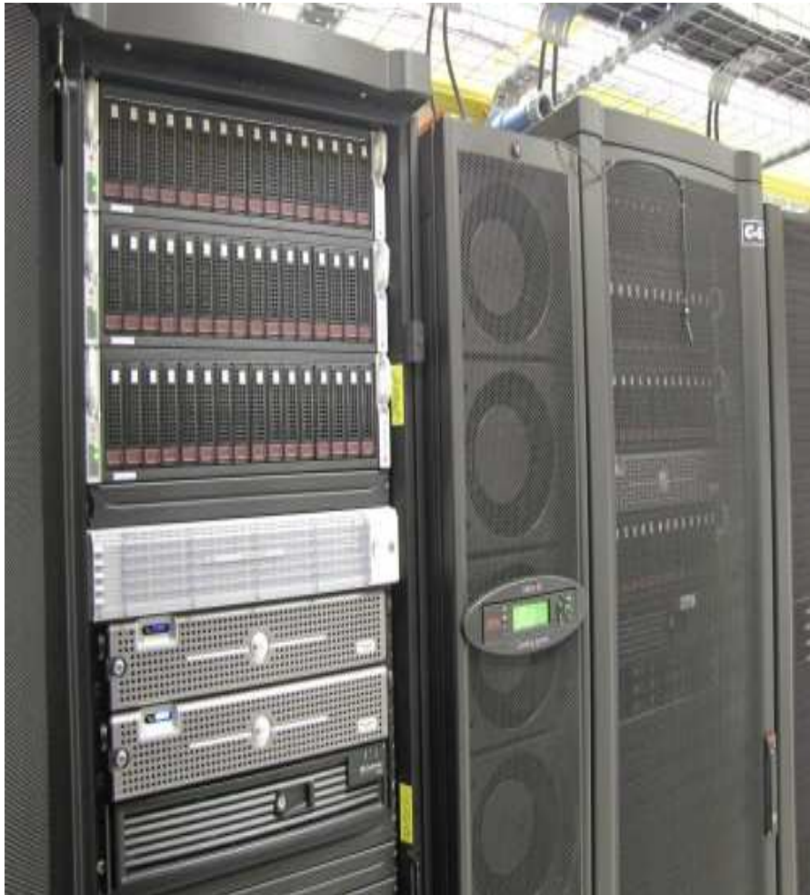
Network-Attached Storage, Arquivo do Técnico
